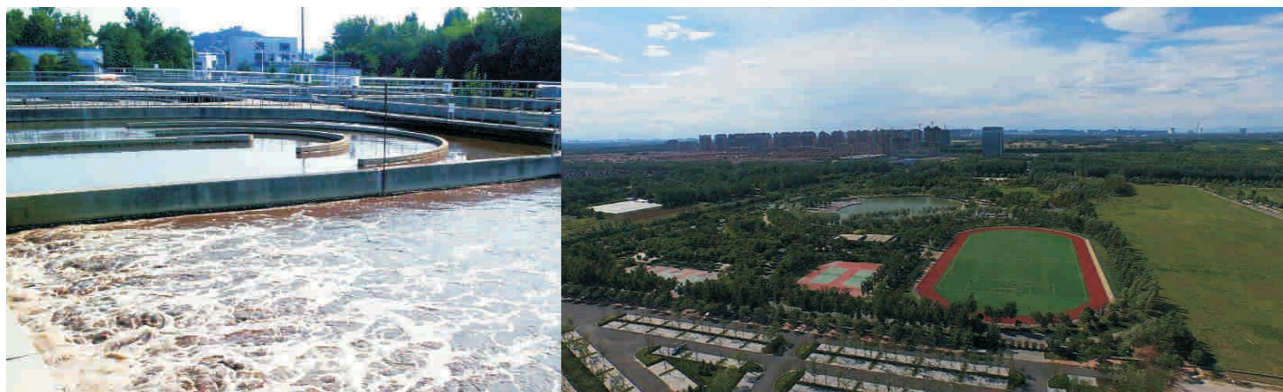
北京市朝阳区污水处理厂
